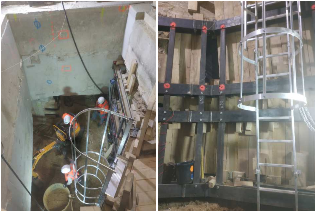
Figure 21. Photos du chantier lors du terrassement le 23/07/2019.
