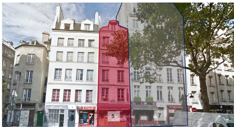
Figure 3. Bâtiments 5 et 7 en Rue des Lavandières
